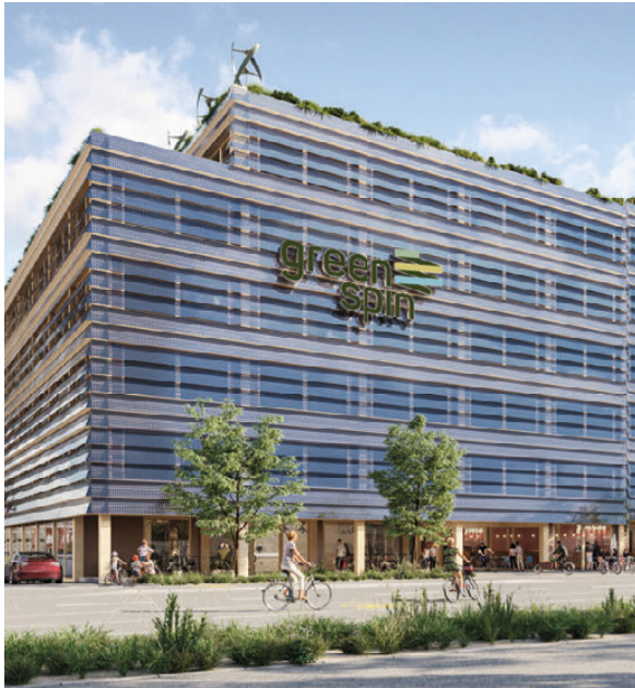
Gebäude mit Fotovoltaikfassade
